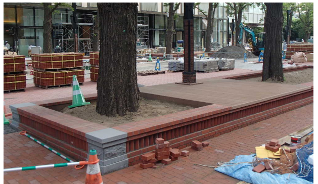
写真-3 植樹樹を連結し、間をデッキ構造とした
