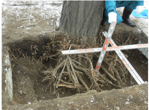
写真-2 既存樹の根系試掘調査による二重根の確認
