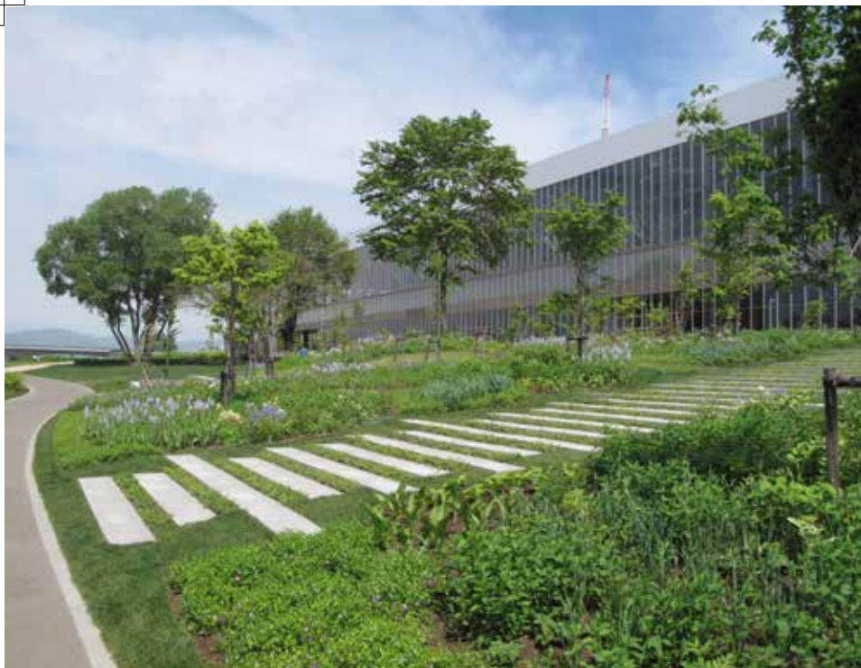
駅と河川とが直接つながる、緑に溶け込んだ大階段
